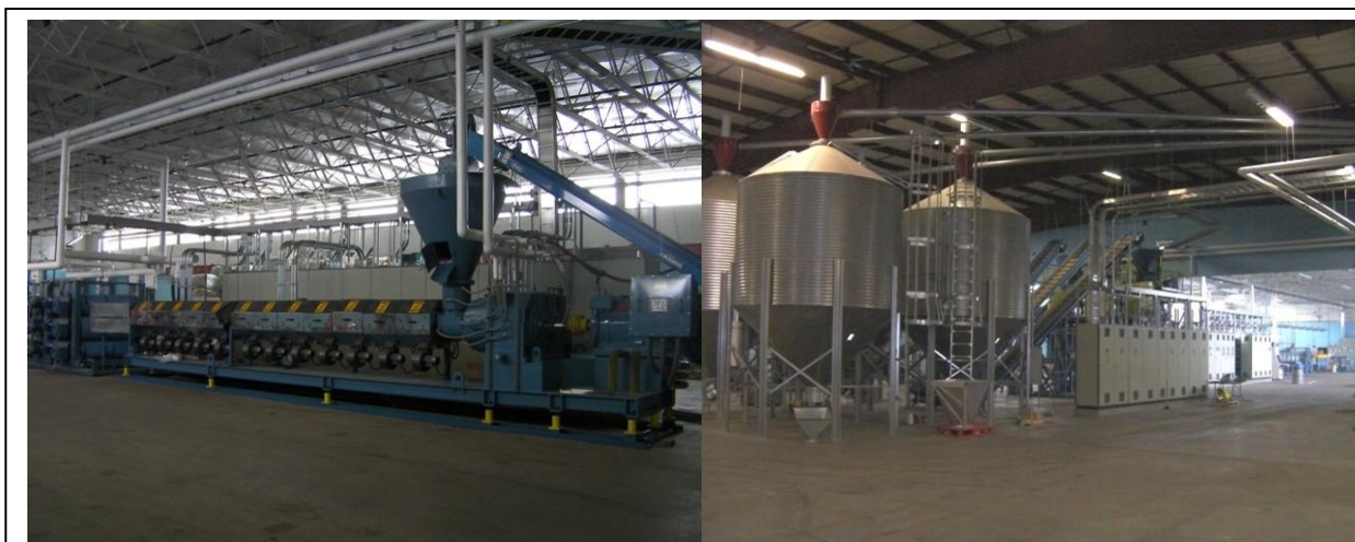
Partial internal plant view – Частичное представление внутри завода.
